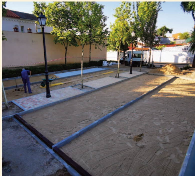
Las obras de las pistas de petanca estarán terminadas en julio.
