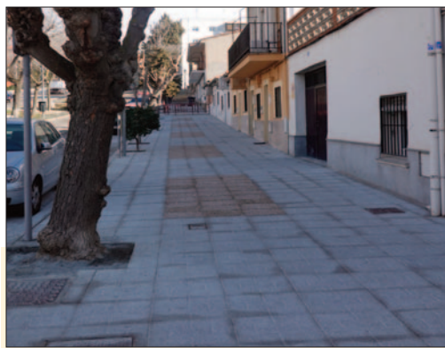
Reparación y mejora de aceras
