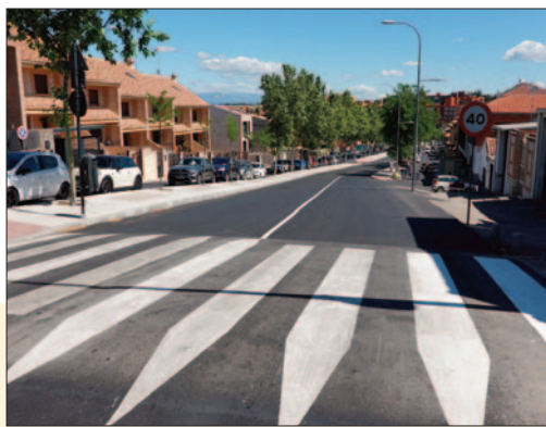
Asfaltado y arreglo de calles
