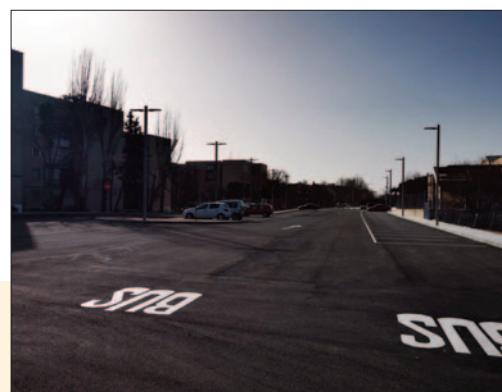
Parking Pabellón La Estación
