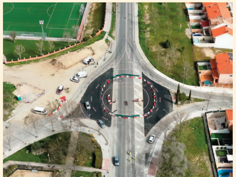
Nueva rotonda en la avenida de Castilla.
