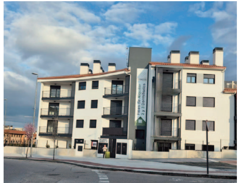
Estas viviendas están ubicadas en la calle Arcángel Gabriel.
