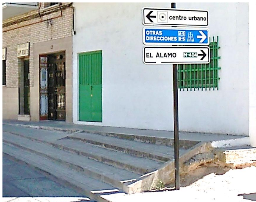
Estado previo a la actuación.
