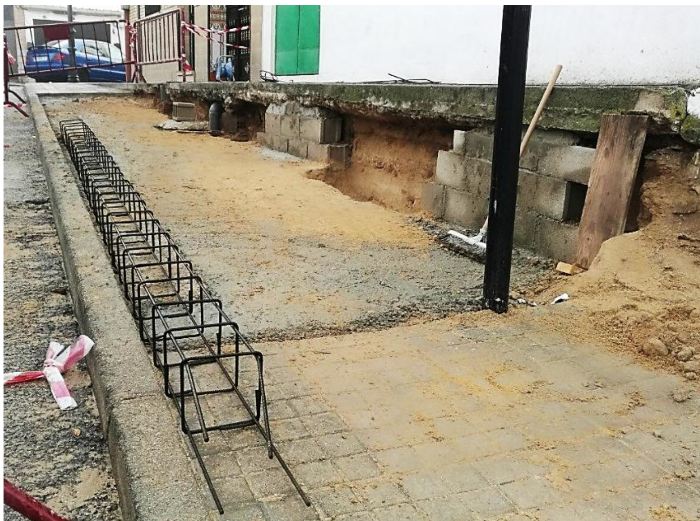
Durante los trabajos.
