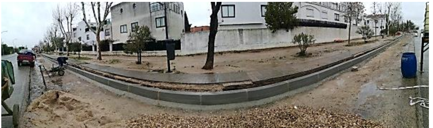
Trabajos en segundo tramo 1ª fase.
