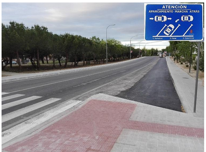
Plazas de aparcamiento diseñadas para aparcamiento marcha atrás
