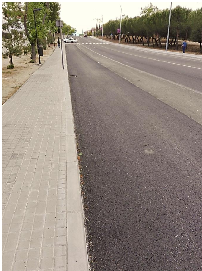
Trabajos terminados a falta de marcas viales en calzada
