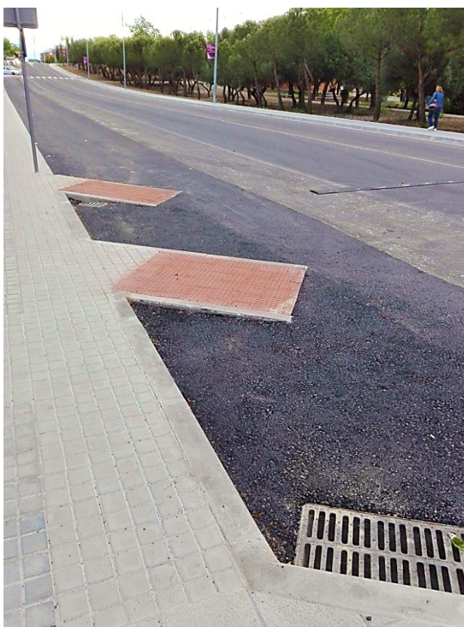
Detalle de plazas de aparcamiento para movilidad reducida
