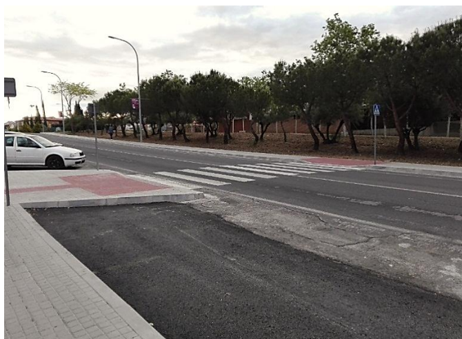
Nuevo paso de peatones
