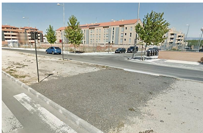
Antes de las obras.
