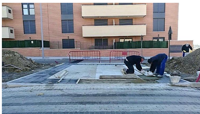
Durante la ejecución.
