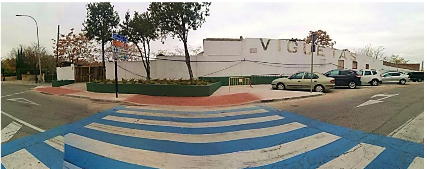
Vista panorámica con los trabajos realizados
