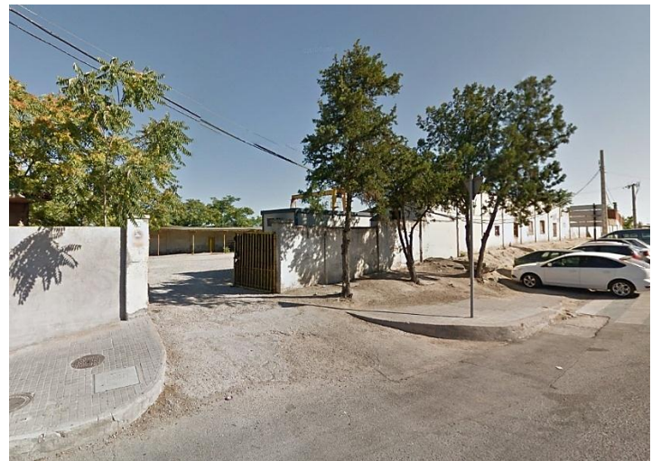
Vista previa a los trabajos de mejora.
