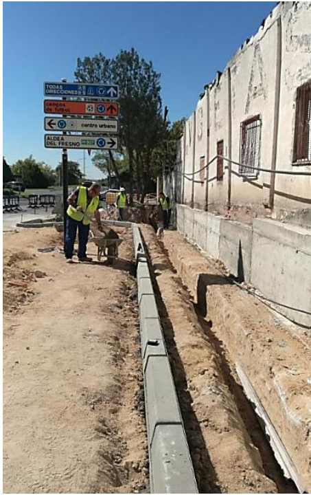
Durante los trabajos
