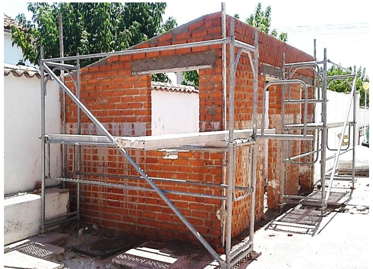
Imagen durante los trabajos
