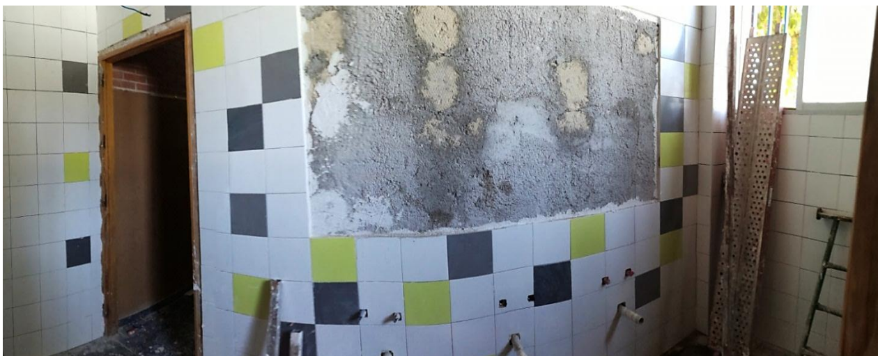
Durante las obras
