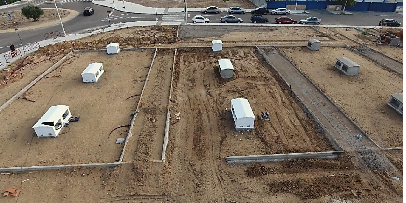
Durante los trabajos
