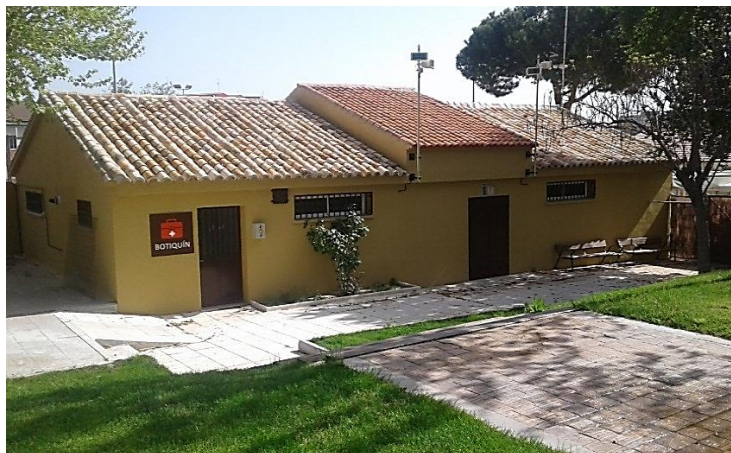
Estado finalizado: vista desde la piscina, y acceso a la misma.
