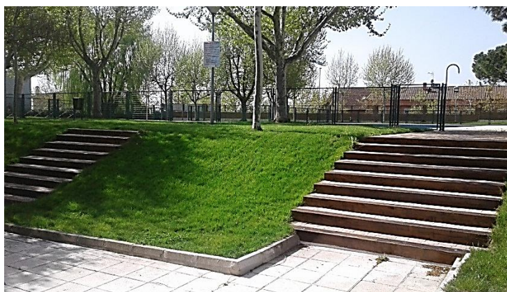
Estado finalizado: acceso y recepción
