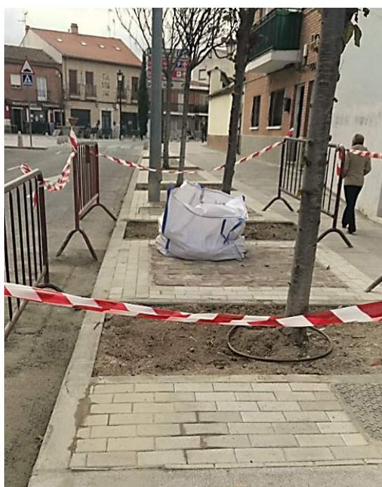
Durante los trabajos.
