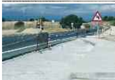
Creación de apeaderos en la parada del cementerio de la M-600.
