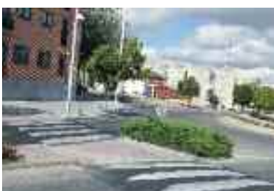
Arreglo de resaltos y repintado de pasos peatonales.
