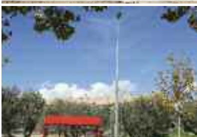
Pavimentación y luminaria de nuevas paradas de autobús.
