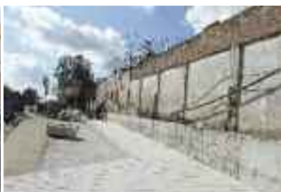
Nueva acera, barbacana, jardineras y cimentación en la cuesta del Águila.
