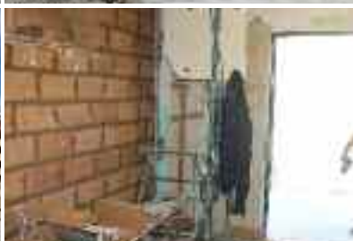
Construcción de oficina para el personal del polideportivo de Covadonga.
