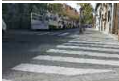
Eliminación de barreras arquitectónicas y repintado de pasos peatonales.
