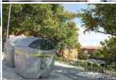
Eliminación de buzones de contenedores antiguos y pavimentación.
