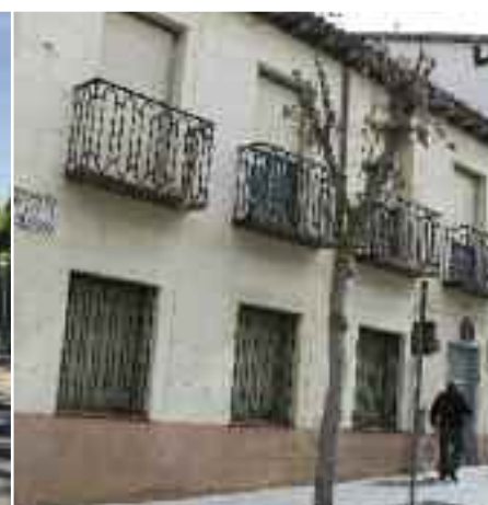
Transformación y adecuación del antiguo Centro de Servicios Sociales en el Centro de Asociaciones de Navalcarnero.
