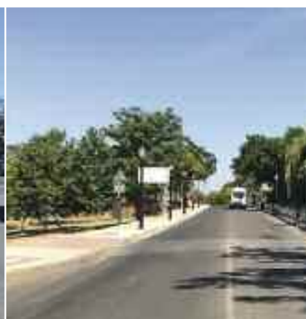
Construcción de una nueva acera en la carretera de Villamanta y dotación de luminarias.
