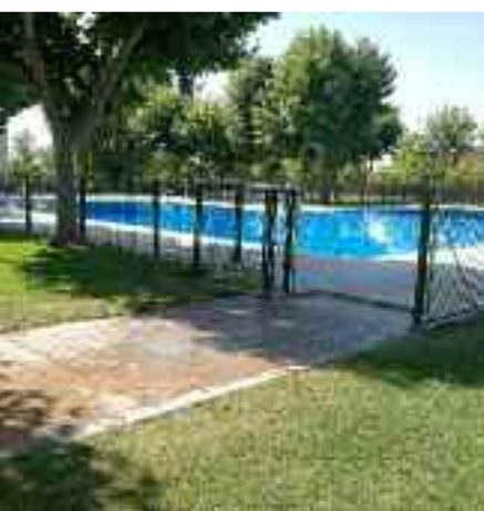
Obras de mejora en los vestuarios, taquillas y zonas de acceso a la piscina municipal de verano.
