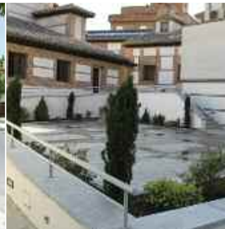
Renovación del patio de la Casa de la Cultura y acondicionamiento de la cubierta del edificio.
